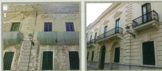
Palazzo storico in Sicilia: la facciata prima e dopo l'installazione dei decori in materiale composito ACELL.
